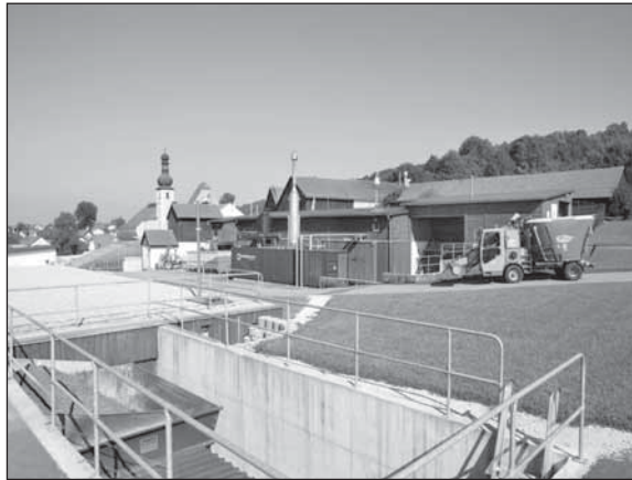
Abbildung 2: Die Biogasanlage fügt sich an das vorhandene Gelände sehr gut ein und genießt entsprechende Akzeptanz.
