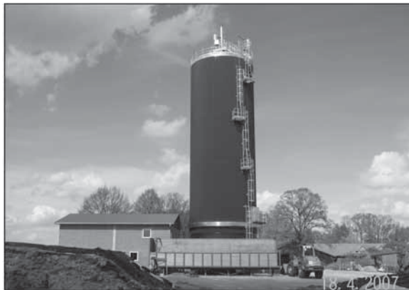
Abbildung 11: Vertikaler Pfropfenstromfermenter (DRANCO-FARM, OWS N.V.)
